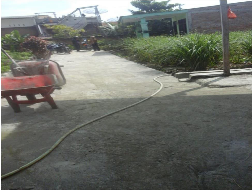
c. Lokasi setelah selesai pengerjaan
