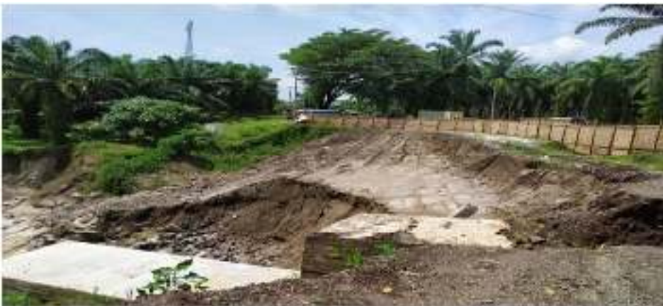
Gambar 3. 2 Lokasi Pembangunan Turap,talup dan bronjong (Sumber : Hasil Penelitian, 2023)
